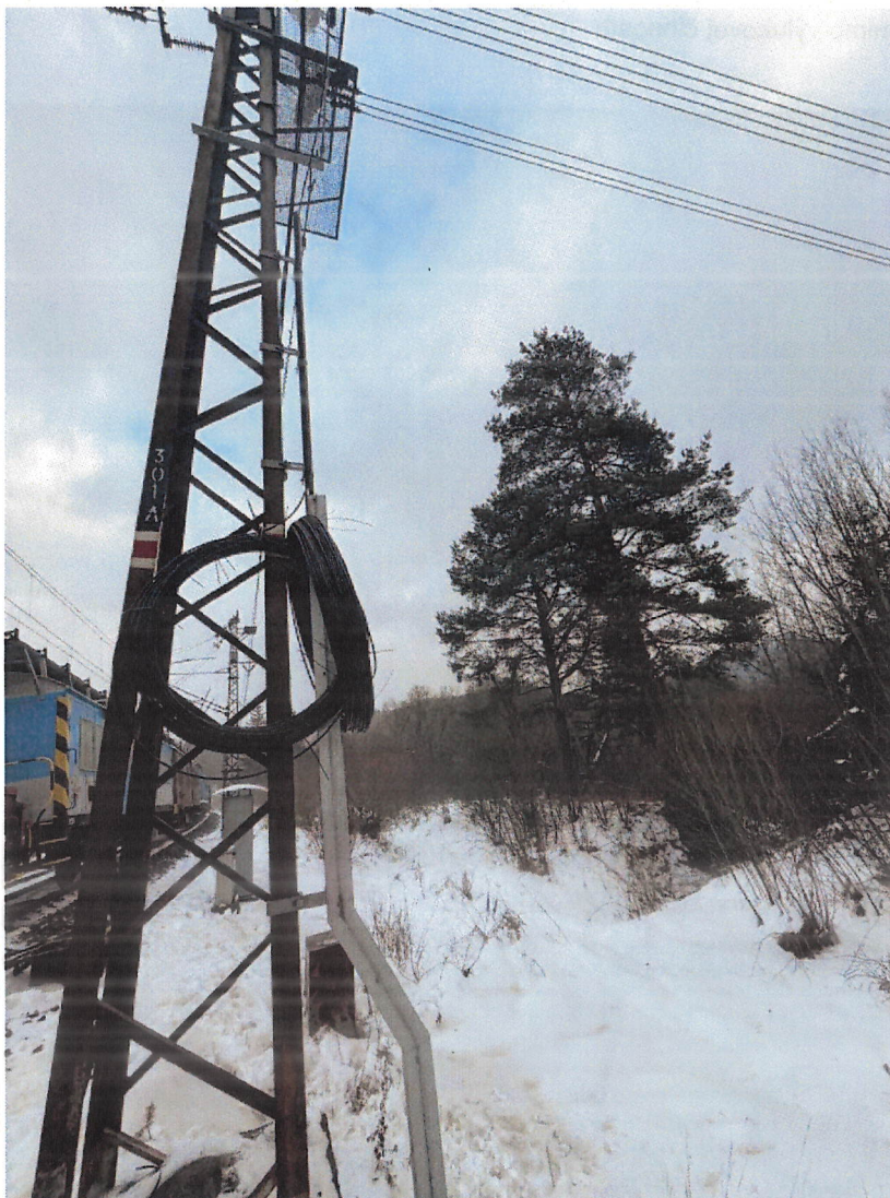
SO 01-35-25A.03 časť Liptovský Mikuláš- Štrba, uchytenie ZOK na TP, PS 01-22-26A.2 časť úsek Liptovský Mikuláš- Štrba, optická kabelizácia Zvod ZOKu do zeme TP301A TNS Kráľová Lehota
