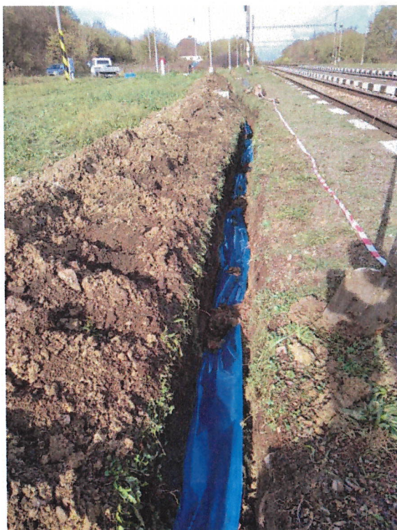
PS 01-22-16A (B) Košice-Čierna nad Tisou, optická kabelizácia – hlavná trať Žst. Nižná Myšľa – výkop káblvej ryhy a pokládka HDPE pre MOK
