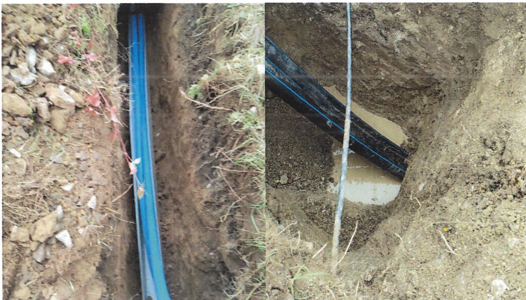
PS 01-22-16A (stavba B) Košice – Čierna nad Tisou, optická kabelizácia – hlavná trať: Barca - výkopy pre ZOK a pokládka žľabov, HDPE, pretlak:
