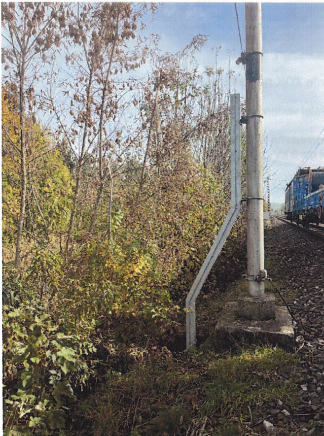
SO 01-35-25A.03 časť Liptovský Mikuláš - Štrba, uchytenie ZOK na TP, PS 01-22-26A.3 časť úsek Liptovský Mikuláš - Štrba, optická kabelizácia
