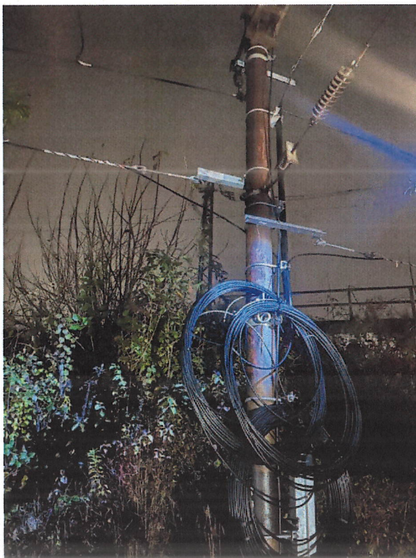
PS 02-22-38A Štrba Košice – optická kabelizácia a SO 02-35-34A_03 časť Kysak-Košice-Barca – uchytenie ZOK na TP: Dočasné uchytenie návinov káblov ZOK na TP 43 PS 02-24-01.16 Spišské Vlachy – Kolínovce, Transformovňa 6/0,4kV Zapojenie novej traťovej TS 116 GSMR do 6kV siete ŽSR.
