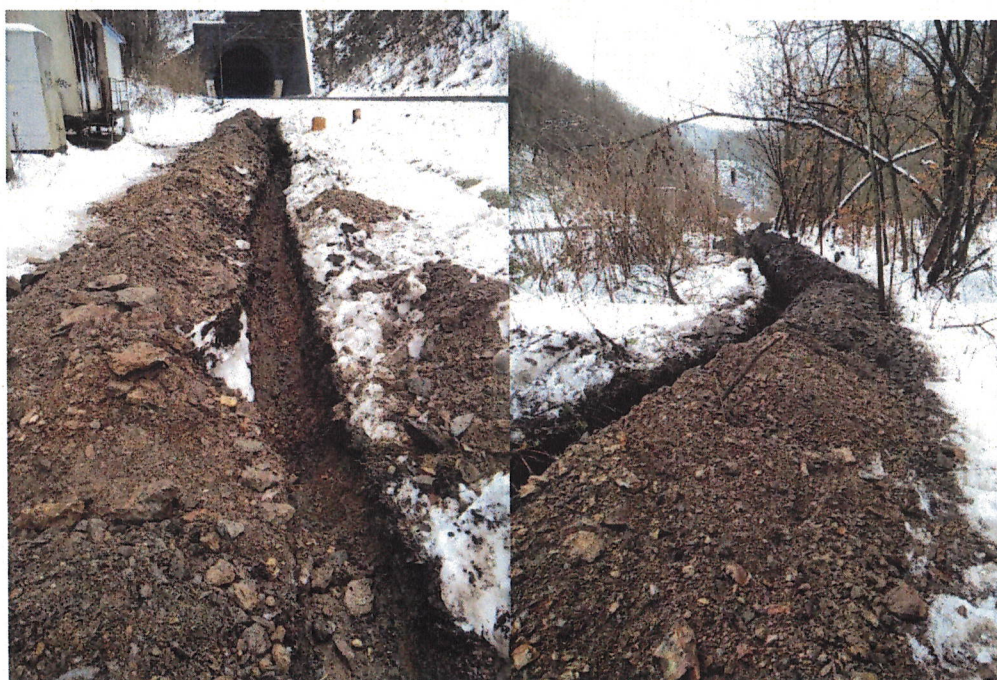
PS 02-22-38A Štrba - Košice, optická kabelizácia – hlavná trať: Bujanovský tunel VP Výkopové práce
